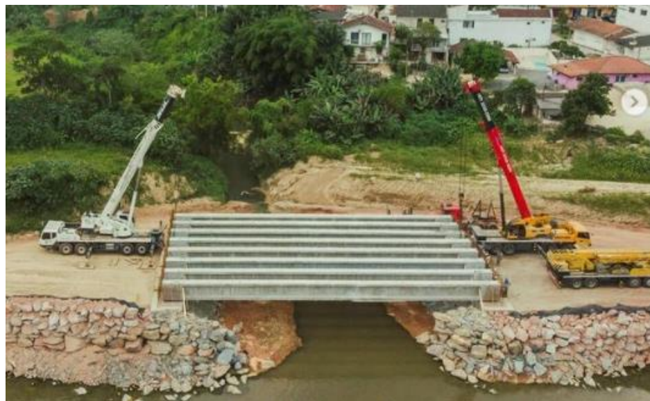
Ponte Ribeirão São Pedro-Brusque-SC
