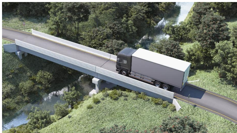
Ponte Córrego Ariado-Barra do Garças-MT
