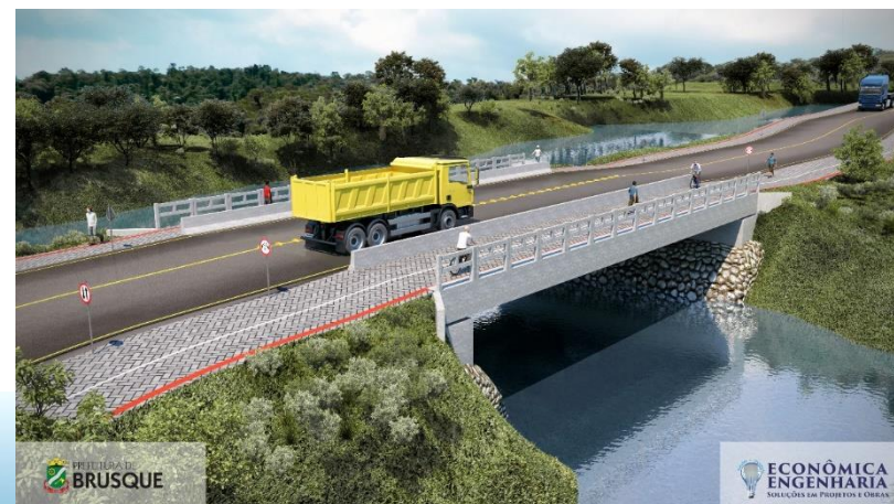
Ponte Ribeirão Limeira-Brusque-SC
