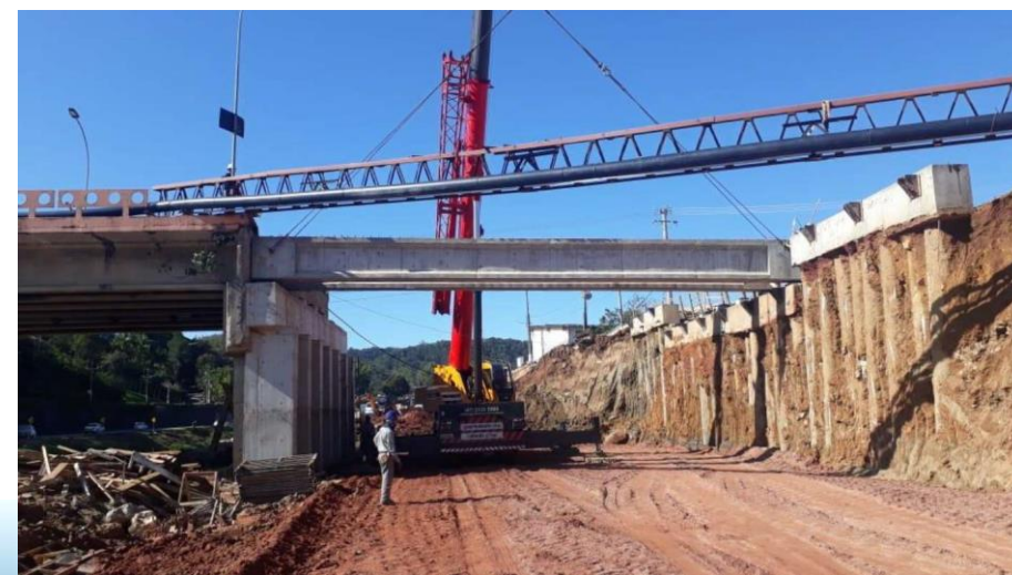
Viaduto Mario Olinger -Brusque-SC
