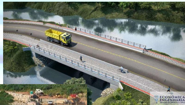
Ponte Ribeirão Limeira-Brusque-SC
