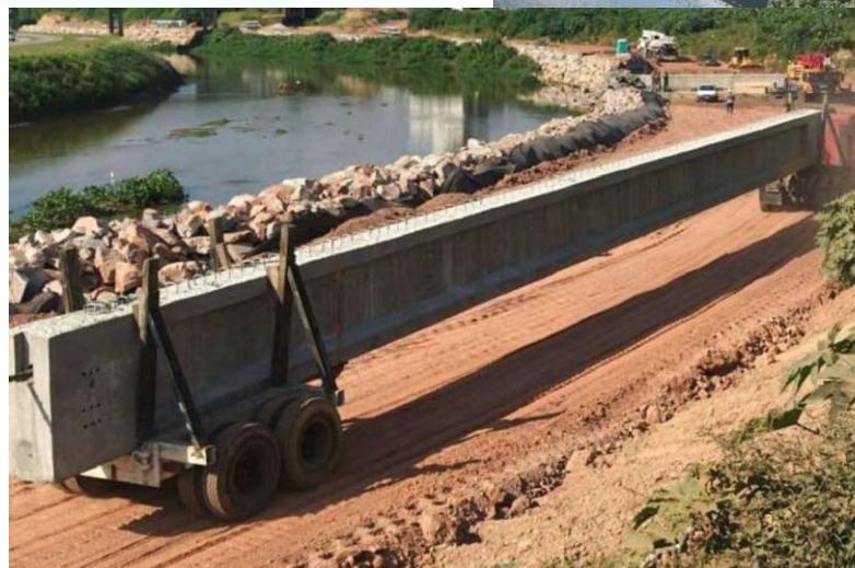
Ponte Ribeirão São Pedro-Brusque-SC
